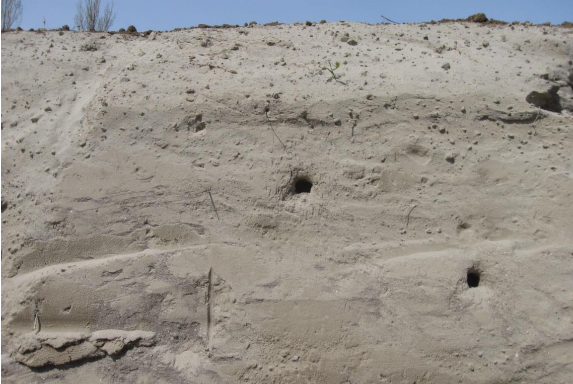
Photo 7 - Premières égratignures autour des trous préfabriqués (2015-05-15)
