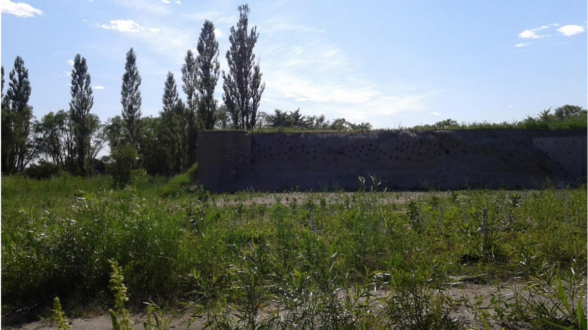
Photo 21 - Aménagements côté sud (2015-07-16)
