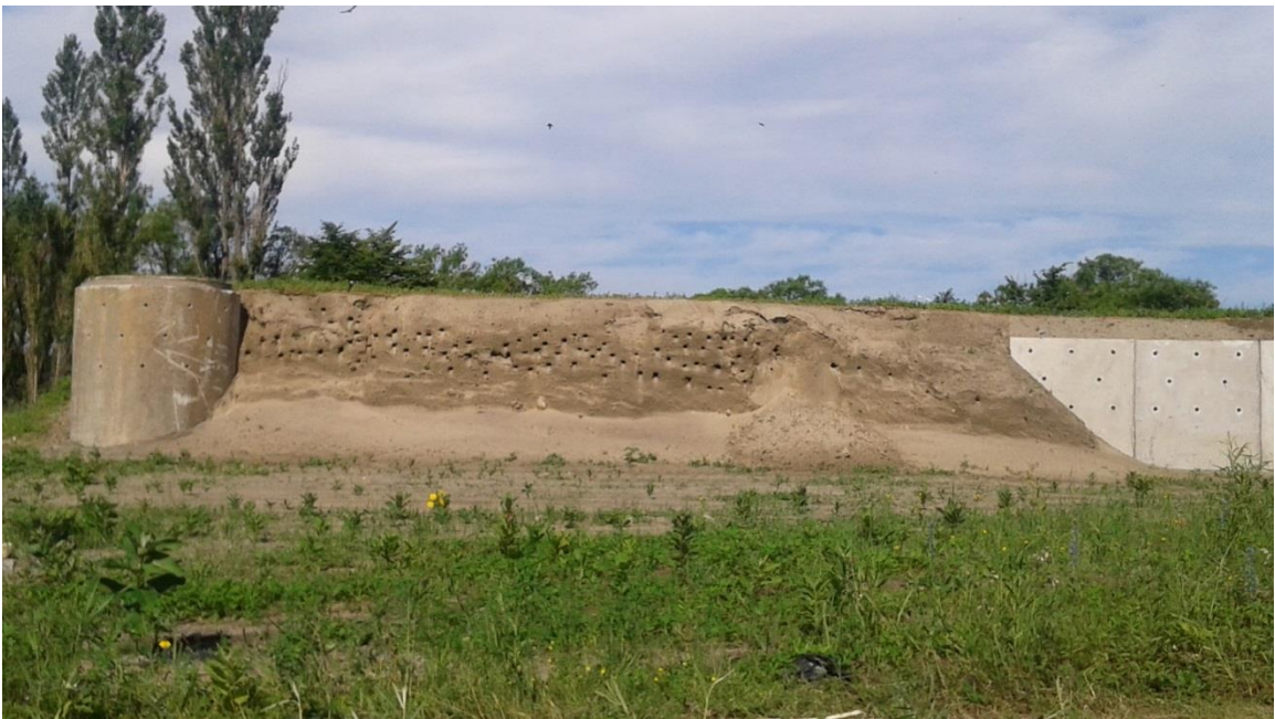
Photo 15 - Aménagements côté sud (2015-07-03)
