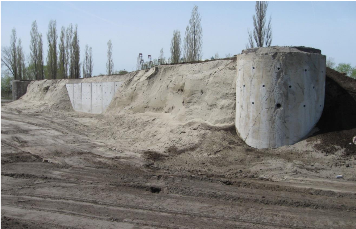
Photo 6 - Vue d'ensemble des aménagements (2015-05-15)
