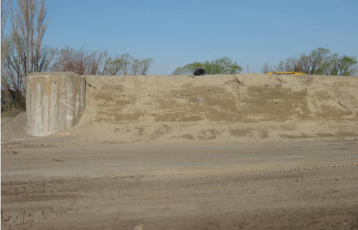
Photo 3 - Vue d'ensemble des aménagements (2015-05-15)
