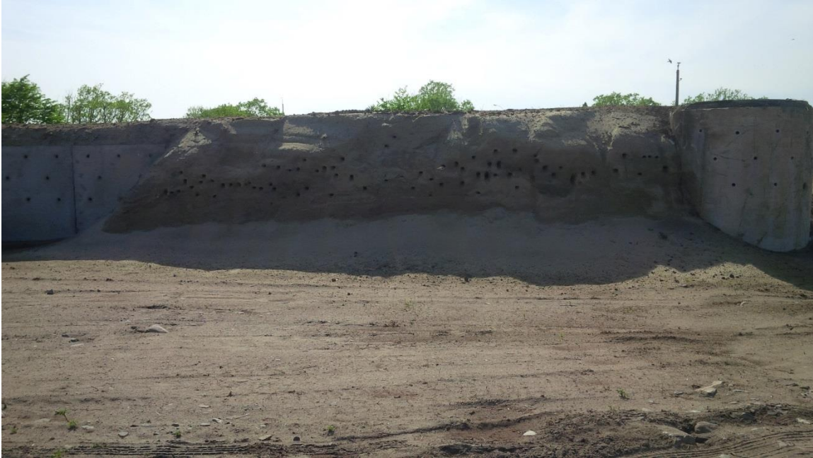
Photo 11 - Terriers creusés par les hirondelles, côté sud (2015-05-29)
