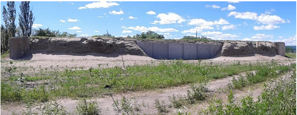
Photo 14 – Vue d’ensemble des aménagements (2015-06-25)
