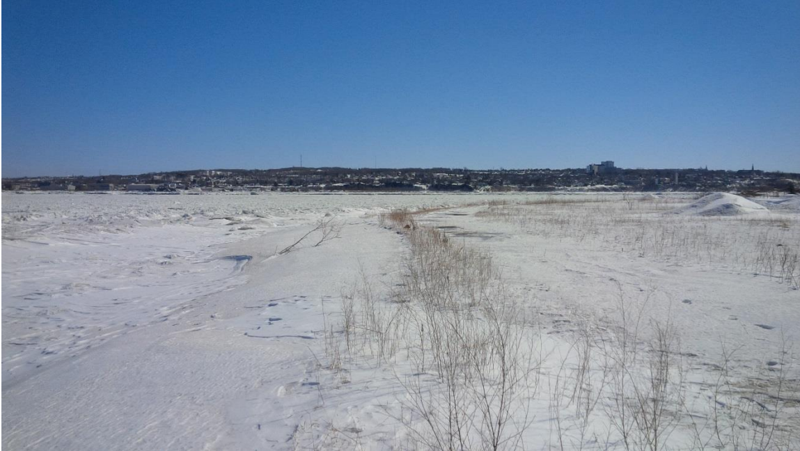
Photo 1 – Site visé par les aménagements, avant les travaux (2015-03-20)
