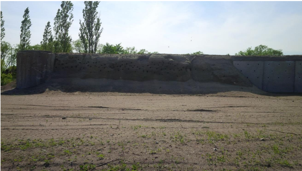
Photo 12 - Terriers creusés par les hirondelles, côté sud (2015-05-29)
