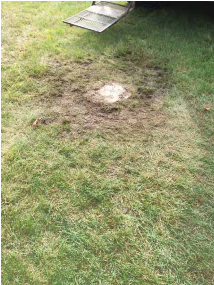
Photo 11 Vue du forage F-01-15 une fois complété.
