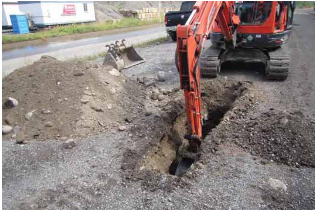
Photo 8 Vue de la tranchée TR26, vue vers le nord-est.
