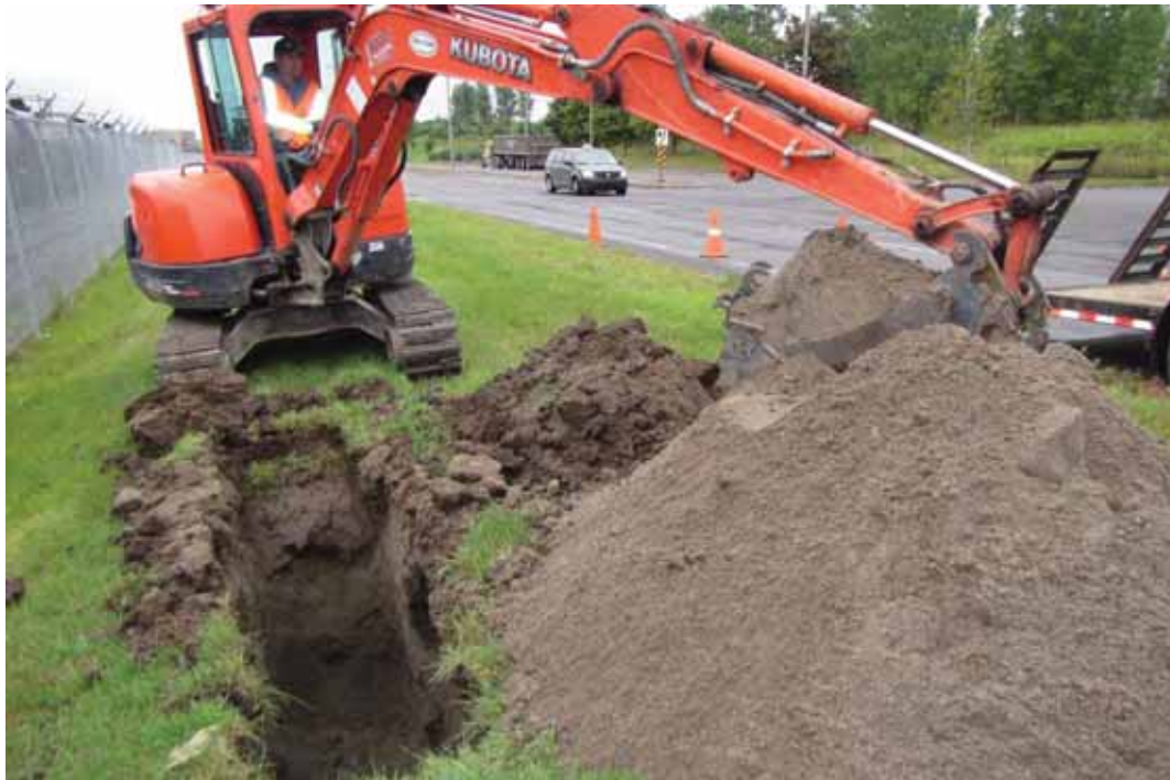
Photo 3 Vue de la tranchée TR5, vue vers l'ouest.
