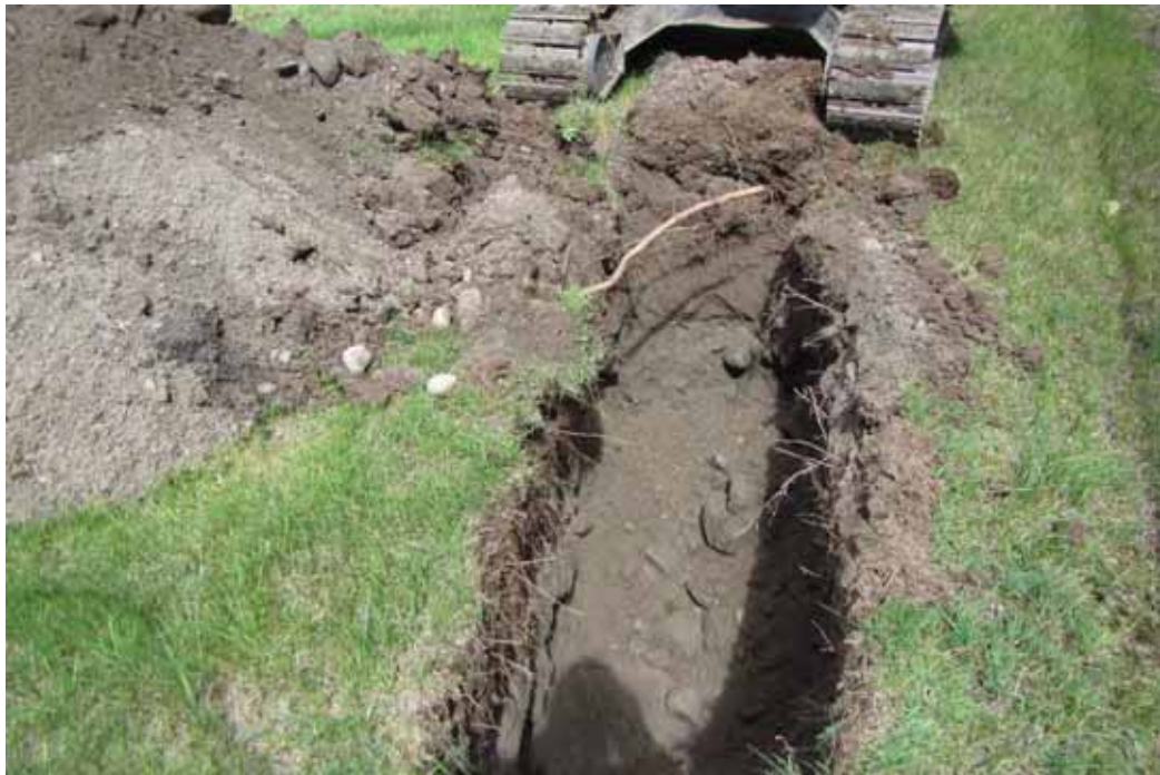
Photo 5 Vue de la tranchée TR15, vue vers le nord-est.
