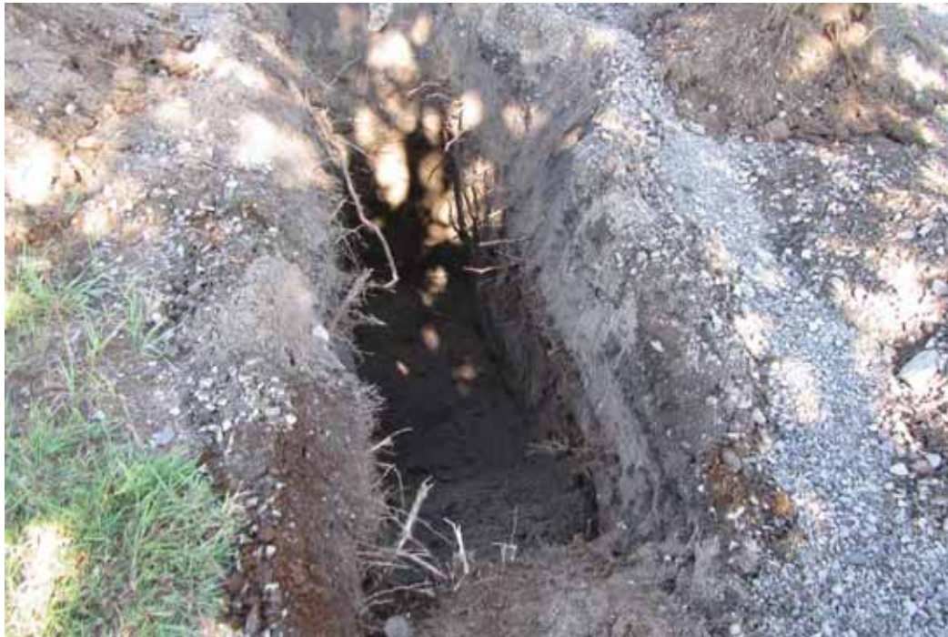
Photo 6 Vue de la tranchée TR18.
