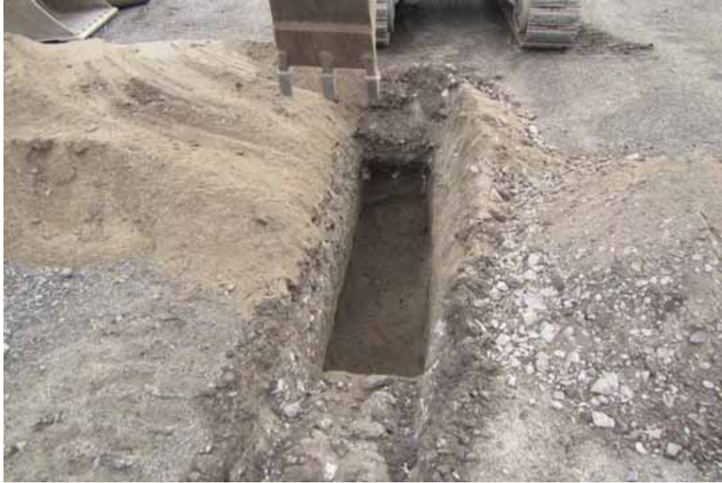
Photo 9 Vue de la tranchée TR31, vue vers l'ouest.
