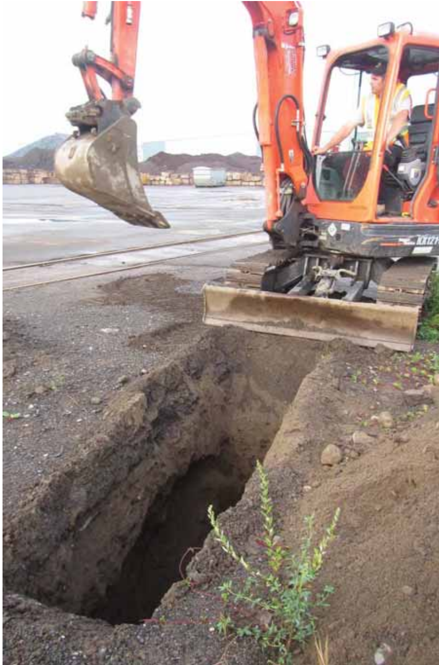
Photo 10 Vue de la tranchée TR34, vue vers le sud-ouest.
