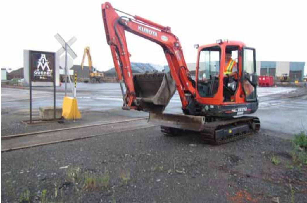
Photo 1 Pelle mécanique utilisée pour réaliser les tranchées.
