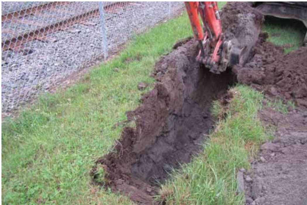
Photo 2 Vue de la tranchée TR1, vue vers le sud-est.
