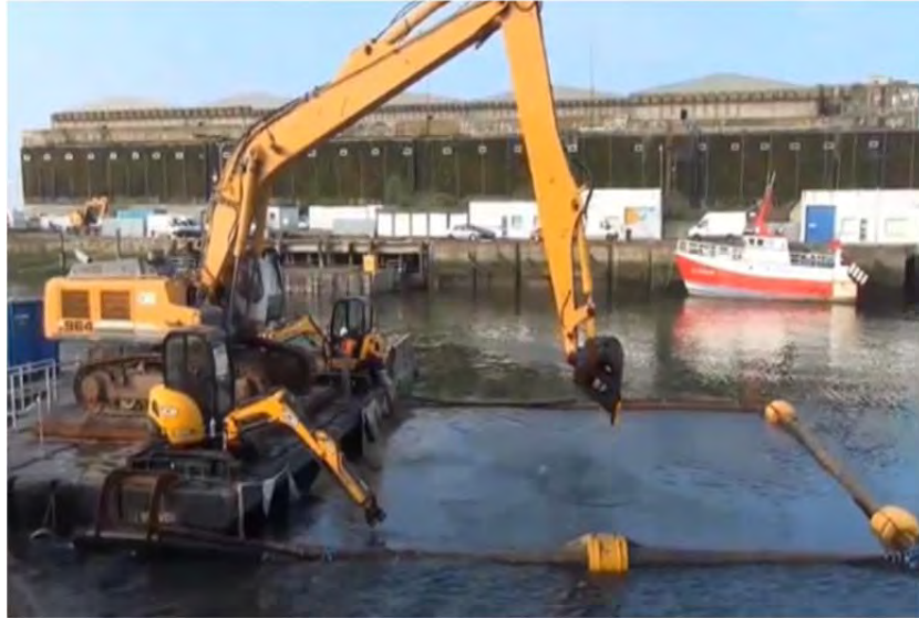
Figure 2 Exemple de drague mécanique travaillant à l'intérieur d'une enceinte constituée d'une barrière flottante
